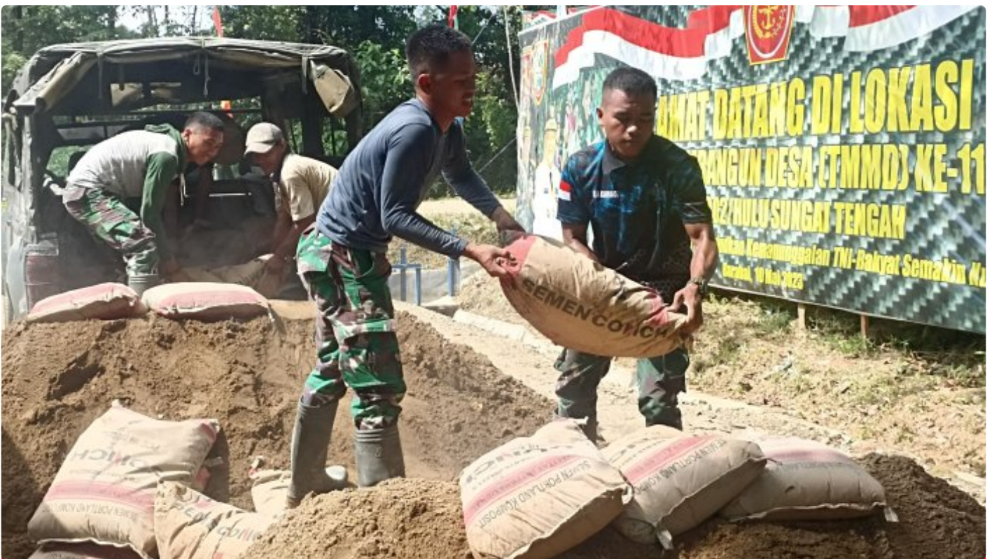
Target Selesai, Material Pengerjaan Jalan Terus Didatangkan
