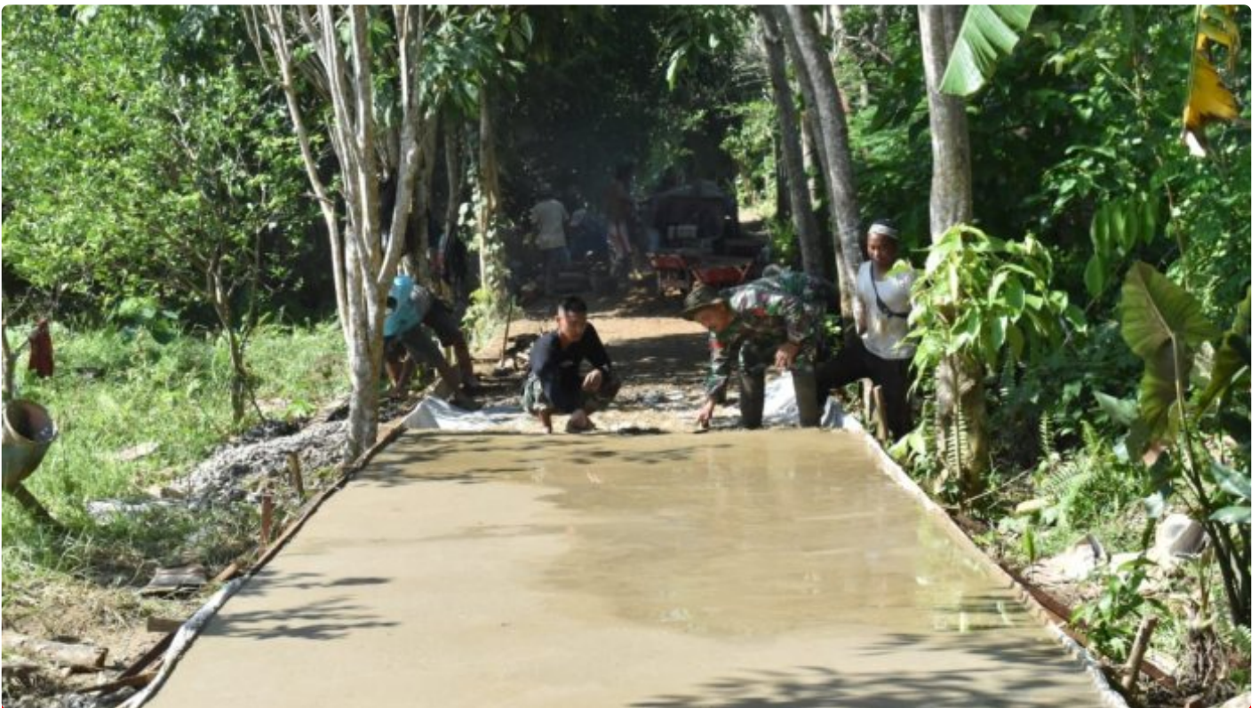
Semangat Warga Hapulang Rampungkan Jalan Desa
