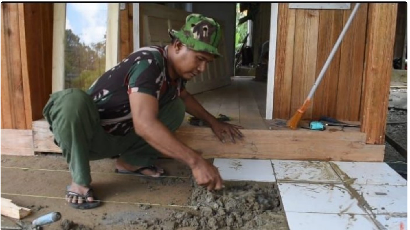
Satgas TMMMD ke-116 Kodim 1002/HST Lakukan Pemasangan Keramik di RTLH
