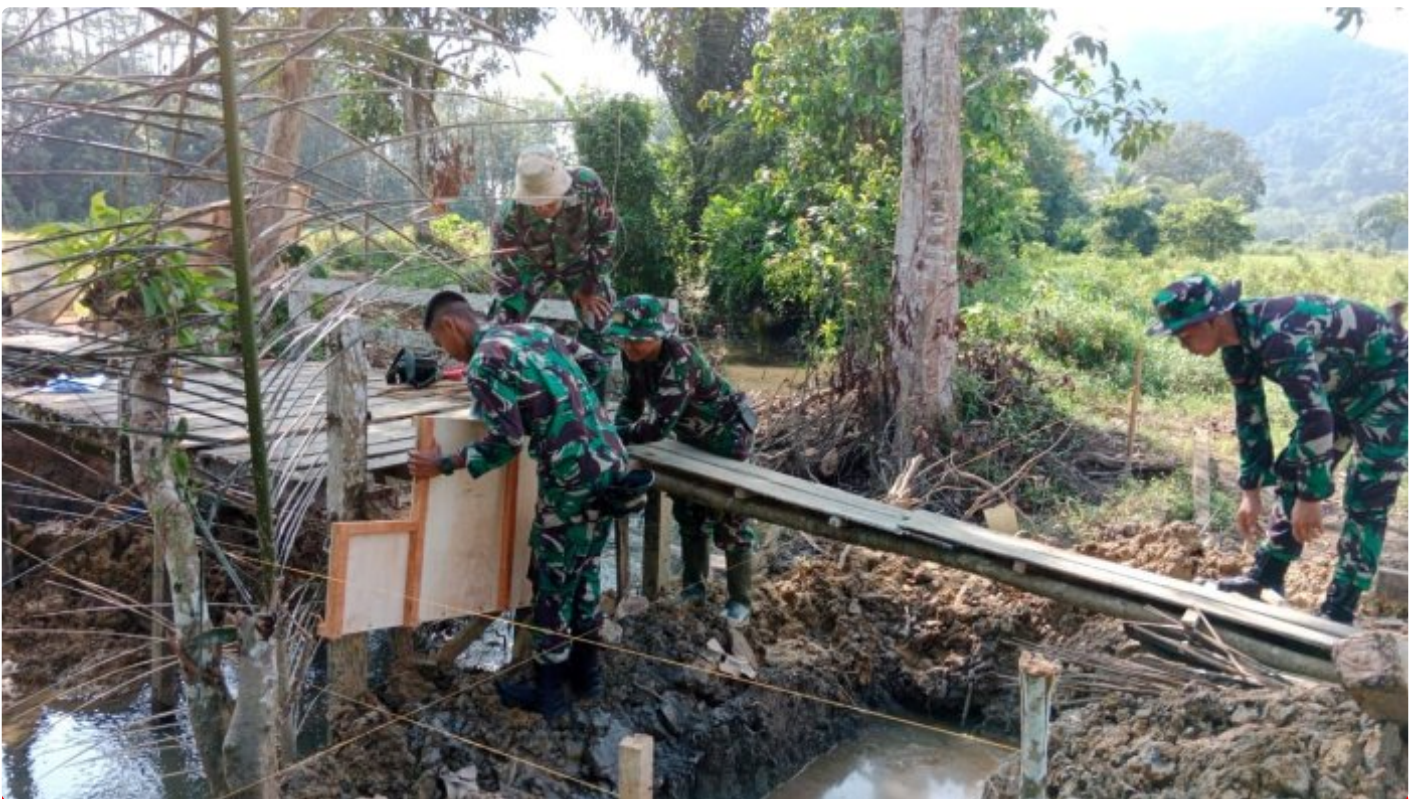
Satgas TMMD ke-116 Kodim 1002/HST Dikerjakan Jembatan
