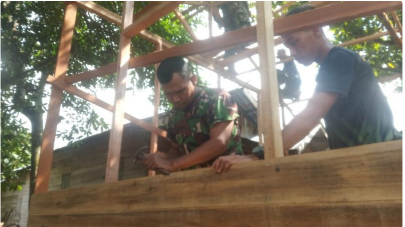
Rehab Tidak Layak Huni TMMD Ke-116 Kodim HST Pasang Dinding Dan Lantai Rumah
