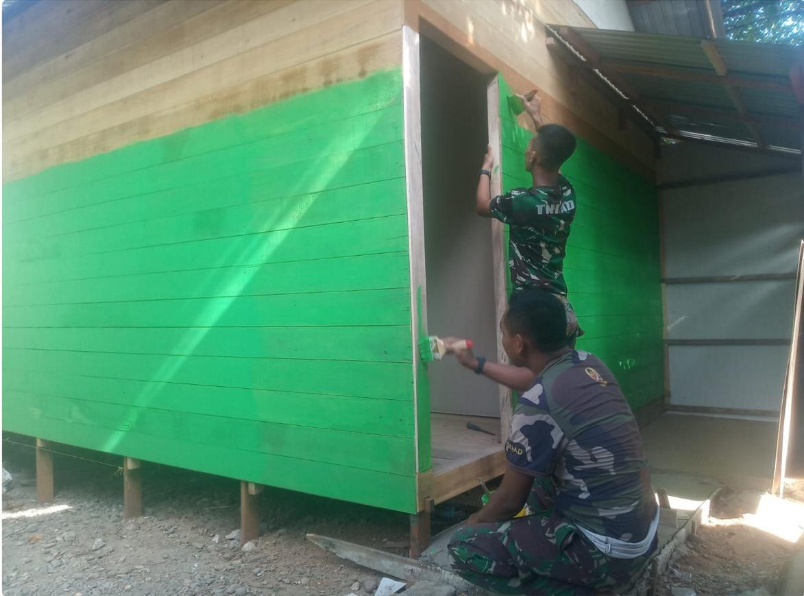
Dijelaskan oleh Kepala Penerangan Satgas TMMMD ke-116 Kodim 1002/HST Lettu Inf Sutanto bahwa sebelum pengecatan dilakukan pembersihan dasar papan dinding dari debu maupun tanah yang menempel sehingga setelah dilakukan pengecatan hasil akan baik dan maksimal,"ujarnya
