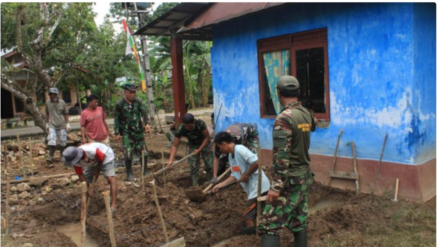
Rehab Musholla Darul Hair Mulai Dikerjakan Oleh Satgas TMMMD ke-116 Kodim 1002/HST
