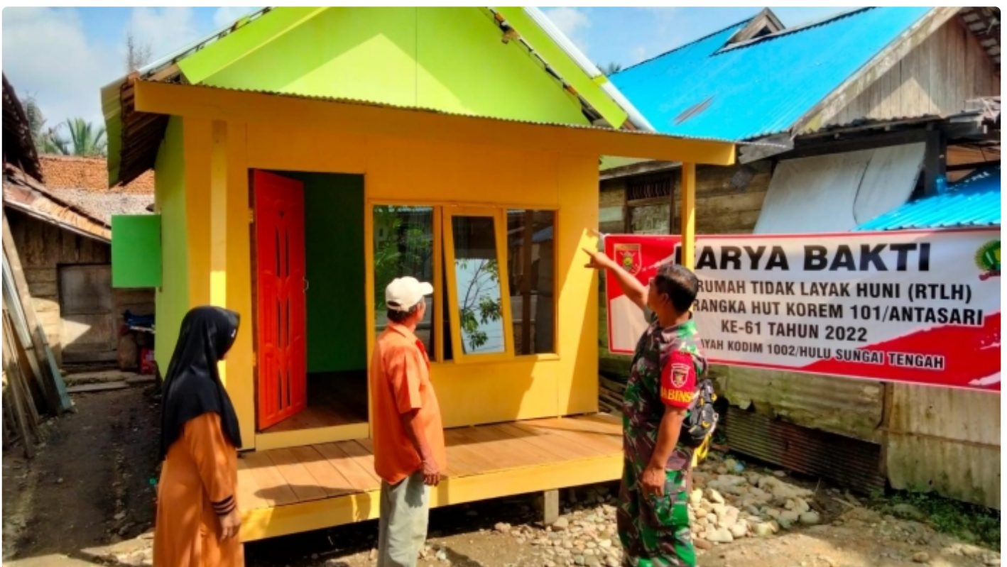
Rampung 100 Persen, 2 Unit Bedah RTLH Kodim 1002/HST Siap Diserahkan
