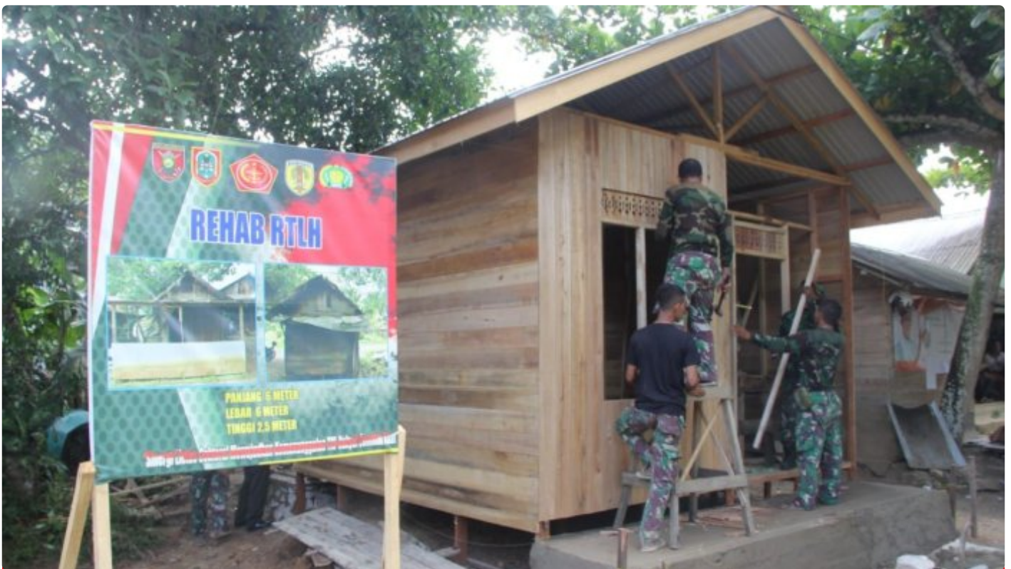
Pengerjaan Rehab RTLH Milik Kakek 86 Tahun Warga Desa Hapulang Capai 55 Persen
