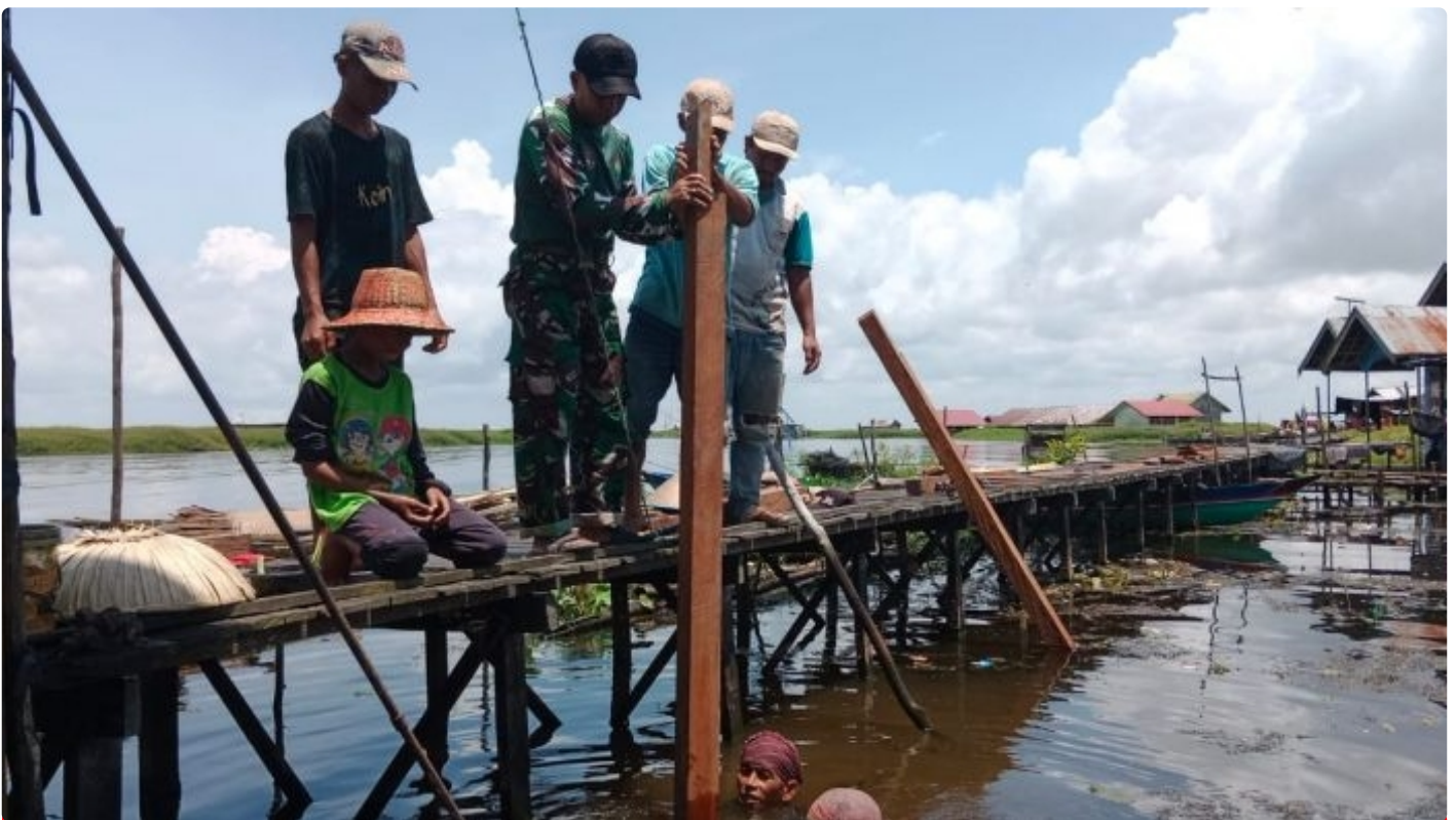
Pemasangan Tiang Penampungan Air
